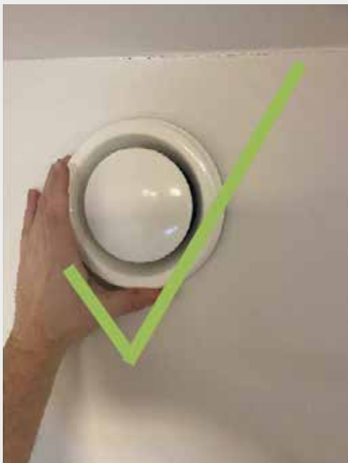
Oikea ote venttiilin irrottamiseksi
