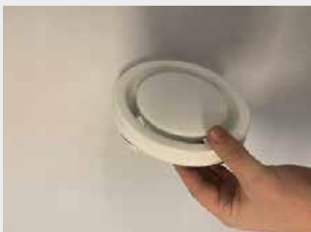
Oikea ote venttiilin irrottamiseksi
