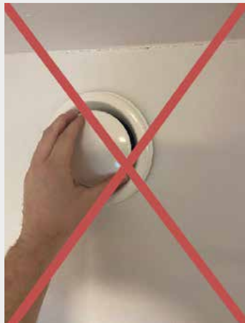
Väärä ote venttiilin irrottamiseksi
